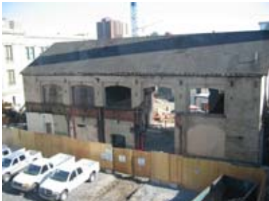
Le Coeur des sciences en restauration
